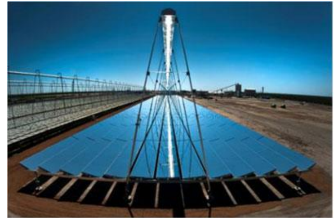
SOLTIGUA Linear Fresnel Collector
